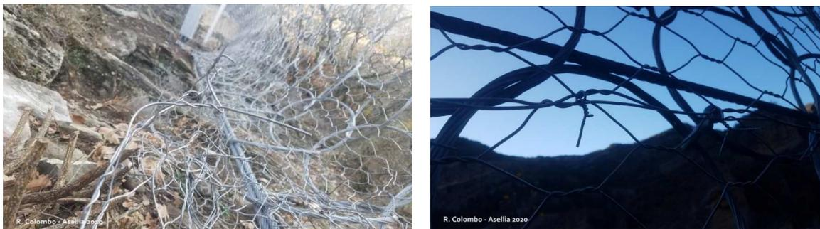
*Photo 21-22 : Extrémité de grillage dépassant sur Ec2*
